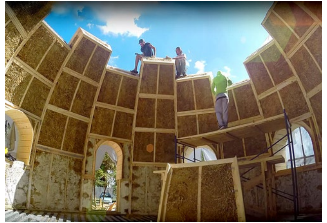
Рис. 3.12 - Теплоізоляція з соломи [49]
