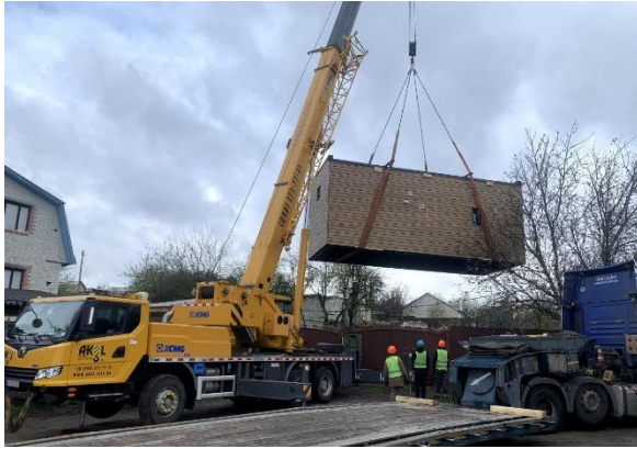
Рисунок 2.2 – Процес встановлення модульного будинку
