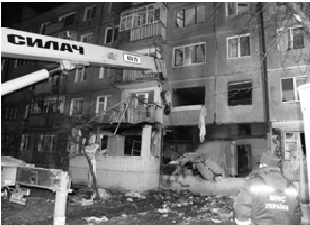
Рис. 1.4. Вибух побутового газу в п'ятиповерховому житловому будинку, м. Чернігів / Partial collapse of the building of the school (collegium) №11 in Chernihiv
