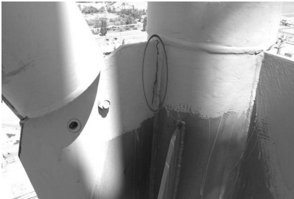
Рис. 1.7. Тріщини нової вентиляційної труби (НВТ-2) Чорнобильської АЕС / Cracks in the new ventilation pipe (NVP-2) of the Chernobyl NPS
