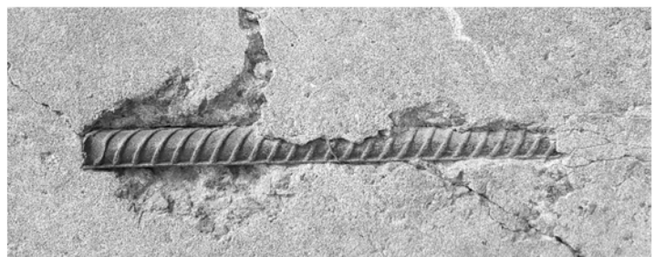
Рис. 2.10. Руйнування залізобетонних конструкцій внаслідок корозійних впливів / Destruction of reinforced concrete structures due to corrosion
