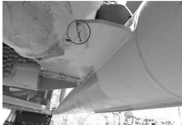
Рис. 1.7. Тріщини нової вентиляційної труби (НВТ-2) Чорнобильської АЕС / Cracks in the new ventilation pipe (NVP-2) of the Chernobyl NPS
