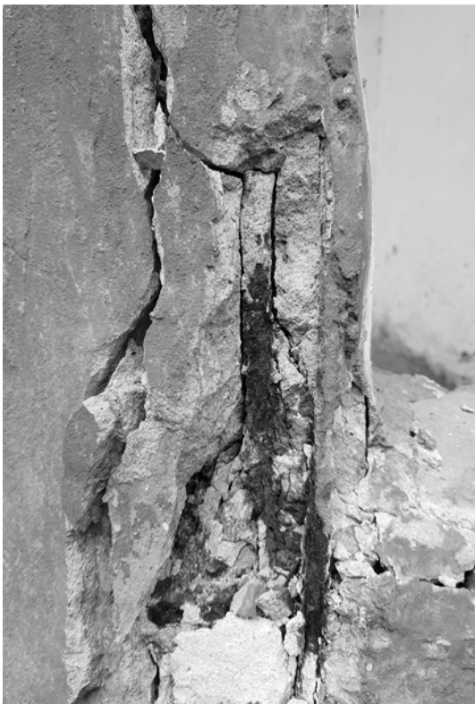
Рис. 2.10. Руйнування залізобетонних конструкцій внаслідок корозійних впливів / Destruction of reinforced concrete structures due to corrosion
