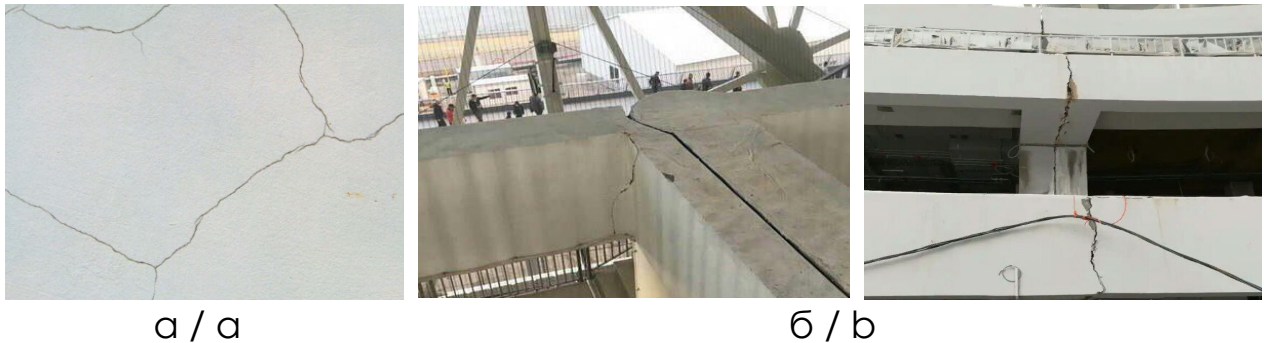
Рис. 3.1. Тріщини будівельних конструкцій:
