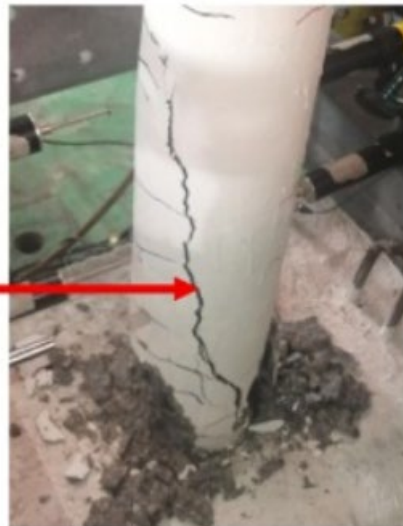
б / б – З'явилися похилі зсувні тріщини / Incline shear cracks appeared
