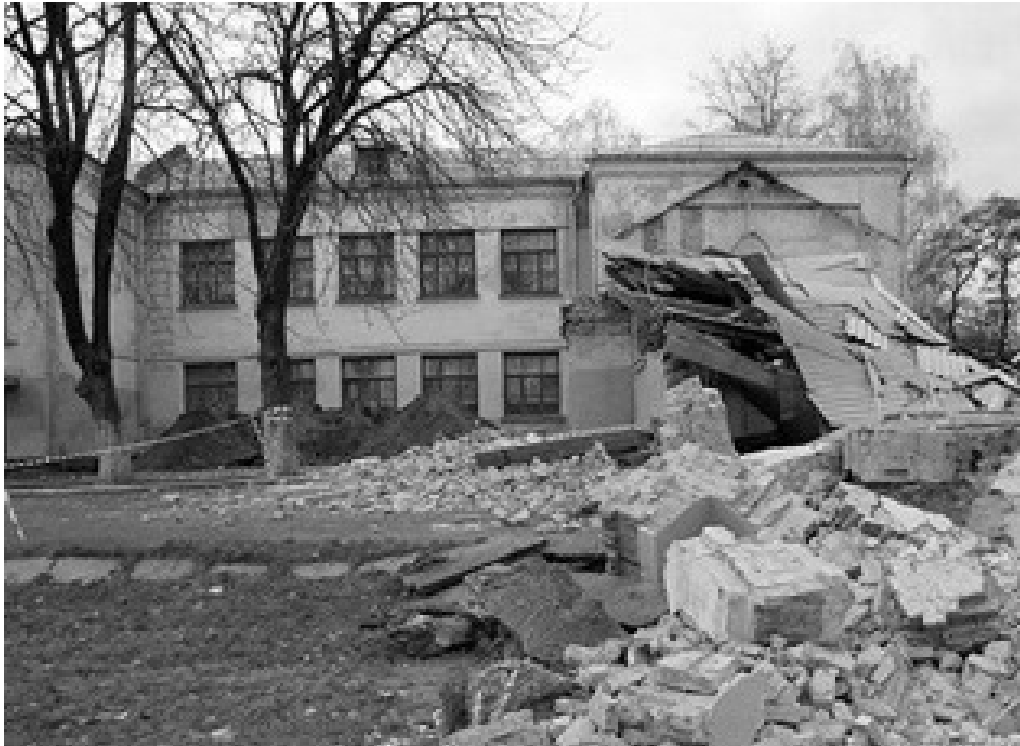
Рис. 1.5. Часткове обвалення будівлі школи (колегіуму) № 11 м. Чернігів / Partial collapse of the building of the school (collegium) № 11 in Chernihiv
