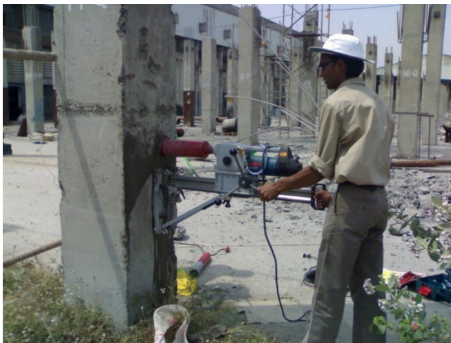
Рис. 6.7. Вирізання керну з бетону для випробування / Cutting a core from concrete for testing
